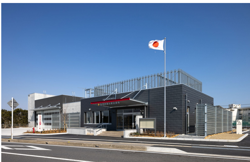
(南消防署白里出張所) 令和4年2月完成
