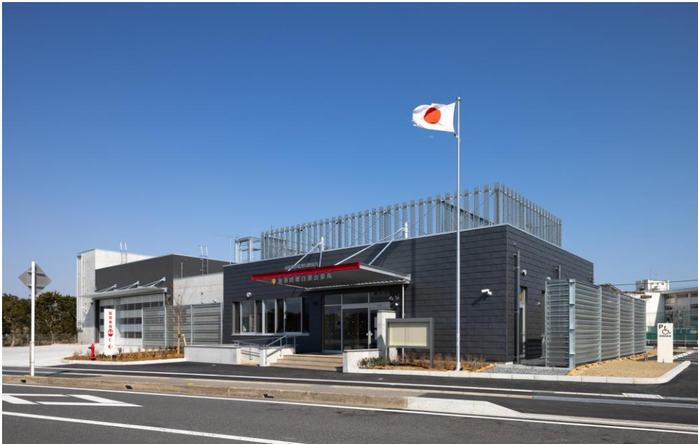
(南消防署白里出張所) 令和4年2月完成
