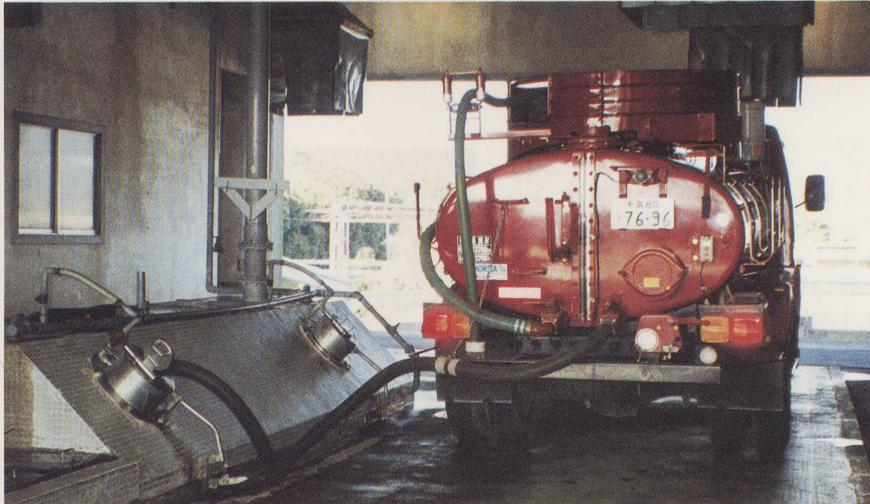
収集された「し尿」や「浄化槽汚泥」は1日平均153kl投入されて処理されています。
